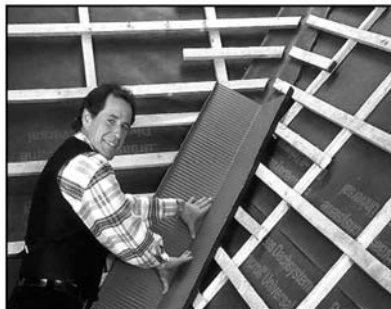
Схема устройства ендовы по настилу
