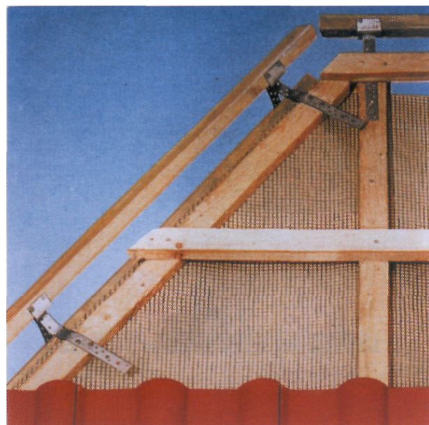
Рис. 7 КРЕПЛЕНИЕ КОНЬКОВОЙ ОБРЕШЕТИНЫ (СМ. РИС. 48, 52, ПРИЛОЖЕНИЕ Г)
